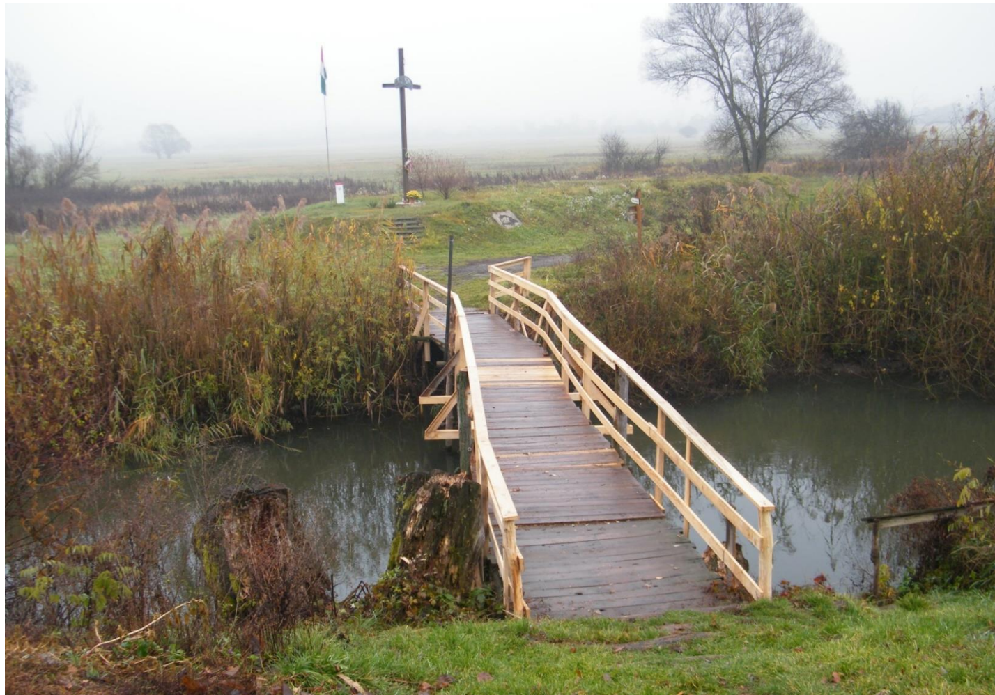
Gerilla hídépítészet az Ipolyon (Órhalom / Ipolyvarbó (Vrbovka))
